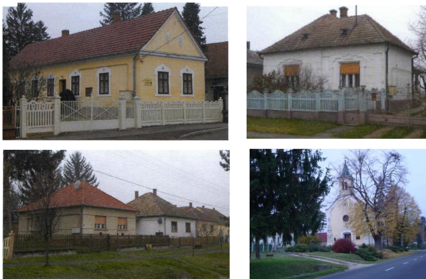
1.14-4. ábra: Ófalu jellegzetes épületei
