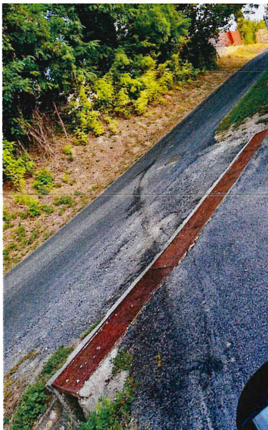
Margaréta – Zalagyöngye utca keresztezésében lévő vízelvezető folyóka és rács
