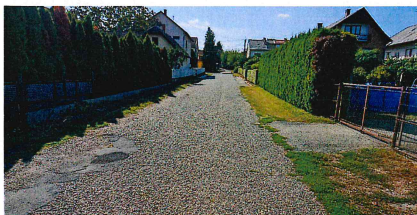
Hegyalja utcáról nyíló 840 hrsz.-ú utca kavicsaszfalt burkolttal – felülete nyitott és fészkes, polírozódott és kis súrlódási ellenállással rendelkezik
