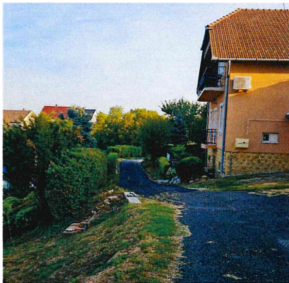
Margaréta utca pályaszerkezet itatott kevert felületi bevonat jellegű, deformált nyitott felületű
