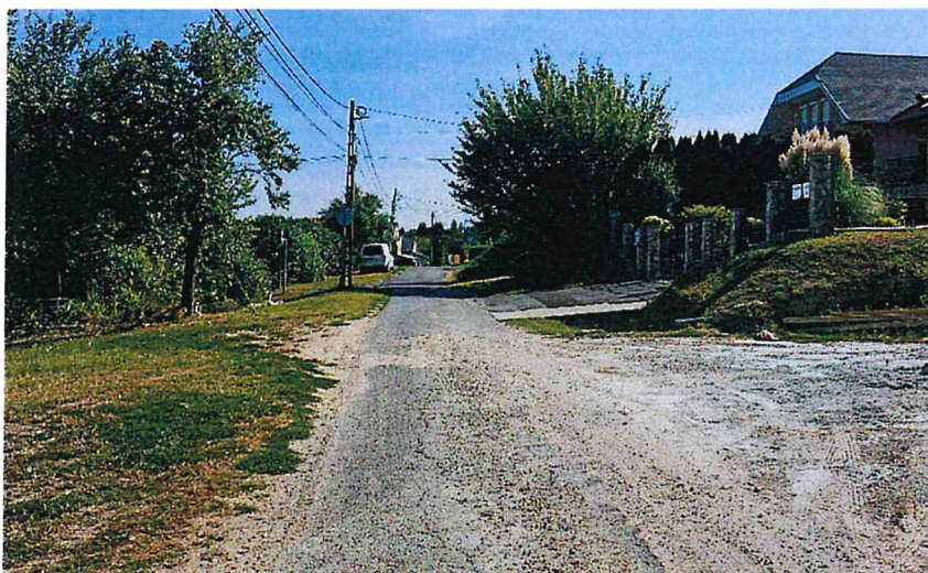
Erősen mozaikos, szétesett, nyomvályús rossz teherbírású burkolat
