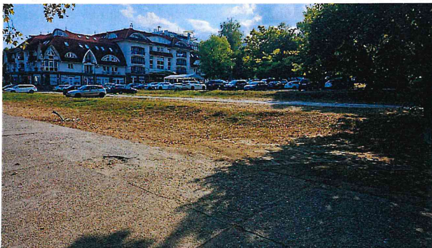
Gyógyfürdő tér közlekedési tere, több szintű parkoló rendezetlen kialakítása
