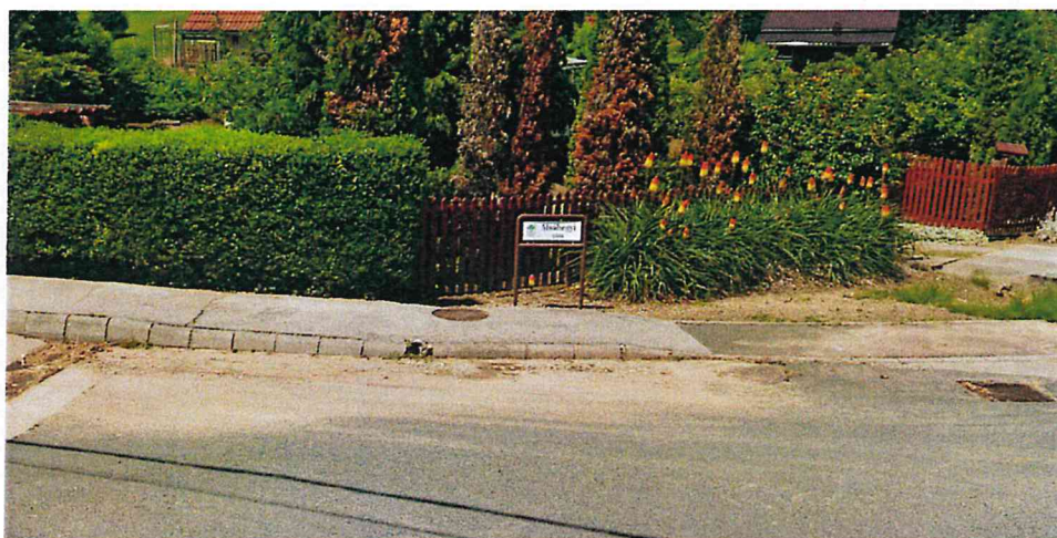
A kiemelt szegély megnyitás és annak szakszerűtlen bekötése a járdán elhelyezett csapadécsatorna aknába
