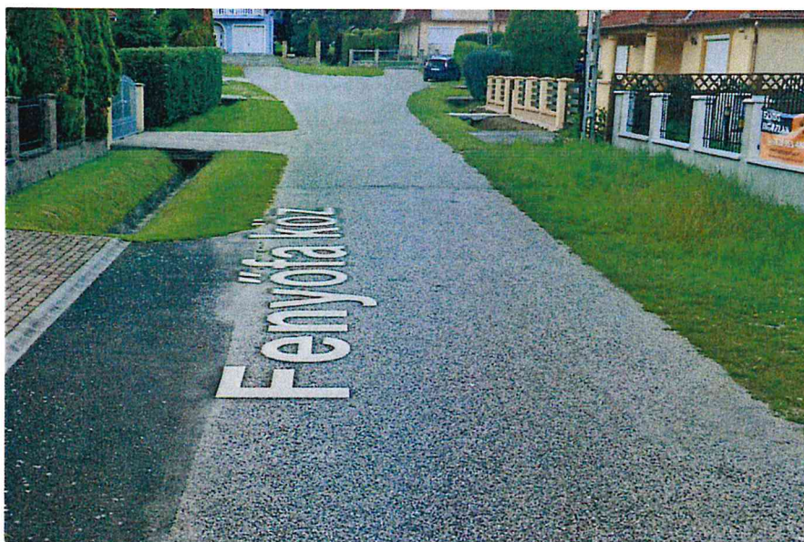
Fenyőfa köz útszakasz nyílt vízelvezető árokszaka és burkolata
