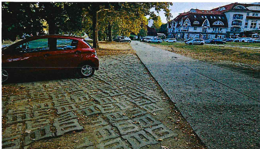
Gyógyfürdő tér közlekedési tere, betontáblás kialakítás
