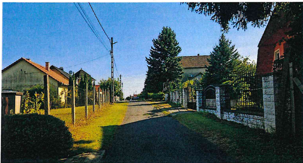
Burkolatsüllyedése a gázvezeték nyomvonalában (1)
