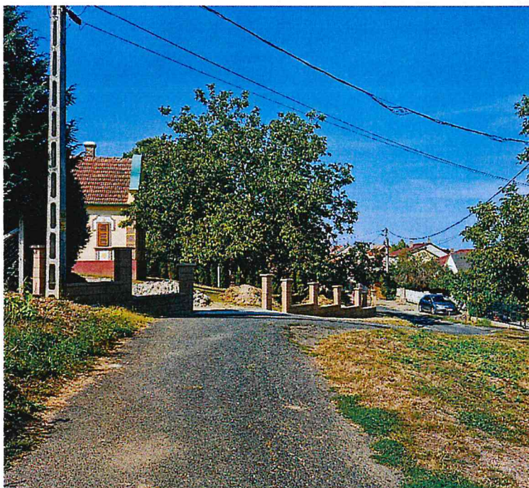
A Gyöngyvirág sor útszakasz elején az inflexió ívben padkahiány és burkolatleszakadás látható
