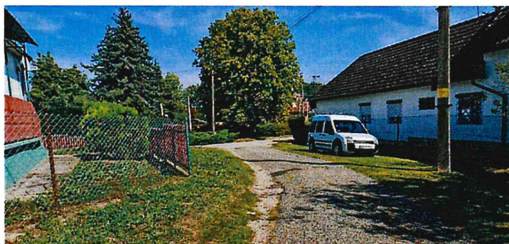
Deformált burkolat, padkahiányos útszakasz
