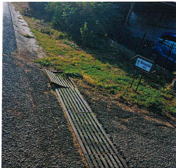
A Diófa utca-Harangláb utca keresztezésében a vízvezető rács kimozdulva
