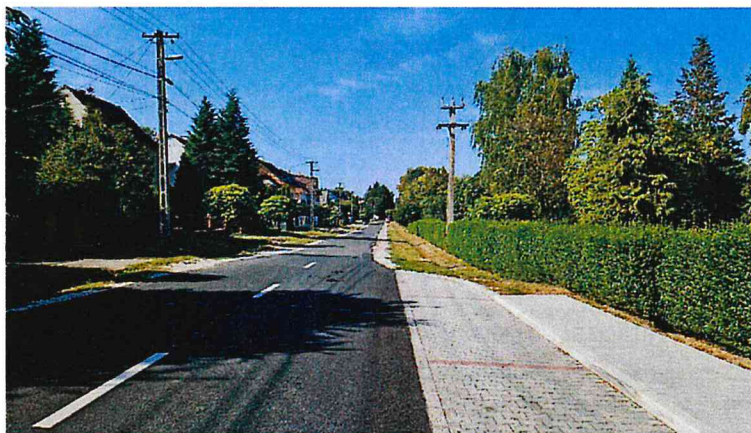
Szőlő utca felújított szakasza
