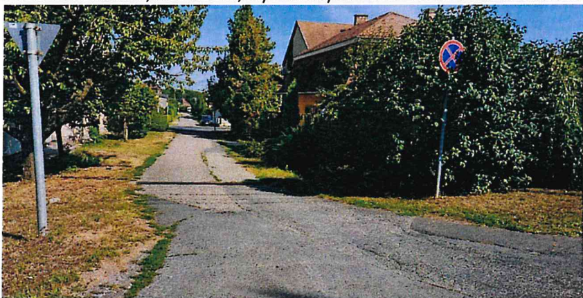
Gyöngyvirág sor – 760/1 hrsz.-ú út csatlakozása, a burkolat aszfalttípusok erősen váltakoznak
