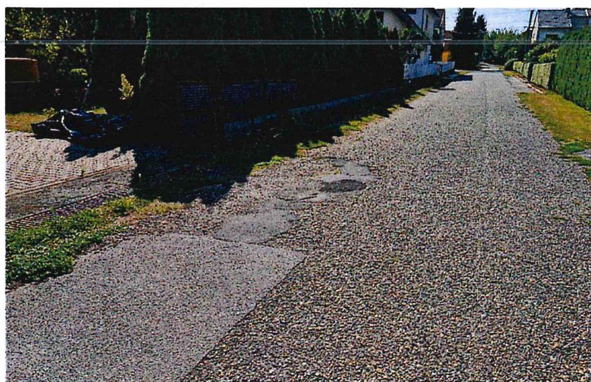
Hegyalja utcáról nyíló 840 hrsz.-ú utca, felületi hibák, hámlások és bomlások lokális javítása
