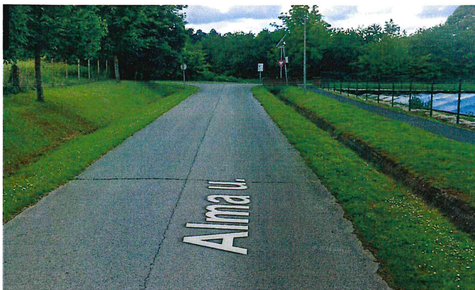
Alma utca táblás hossz- és keresztrepedések a burkolaton
