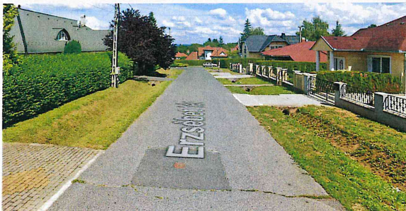
Reflexiós keresztrepedésre példa az útszakaszon
