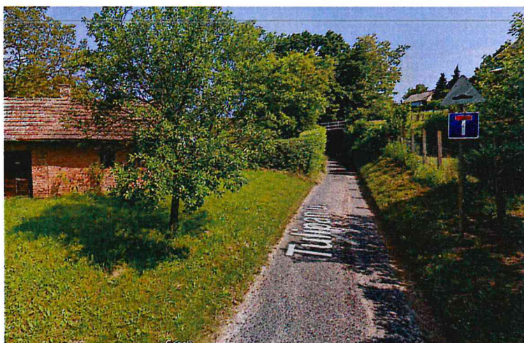
Tulipán utca szűk, erősen úrszelvényes stabilizált földút jellegűt
