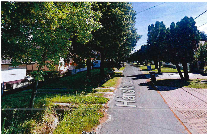
Hársfa utca jellemző útképe, helyenként reflexiós repedések láthatók a burkolaton
