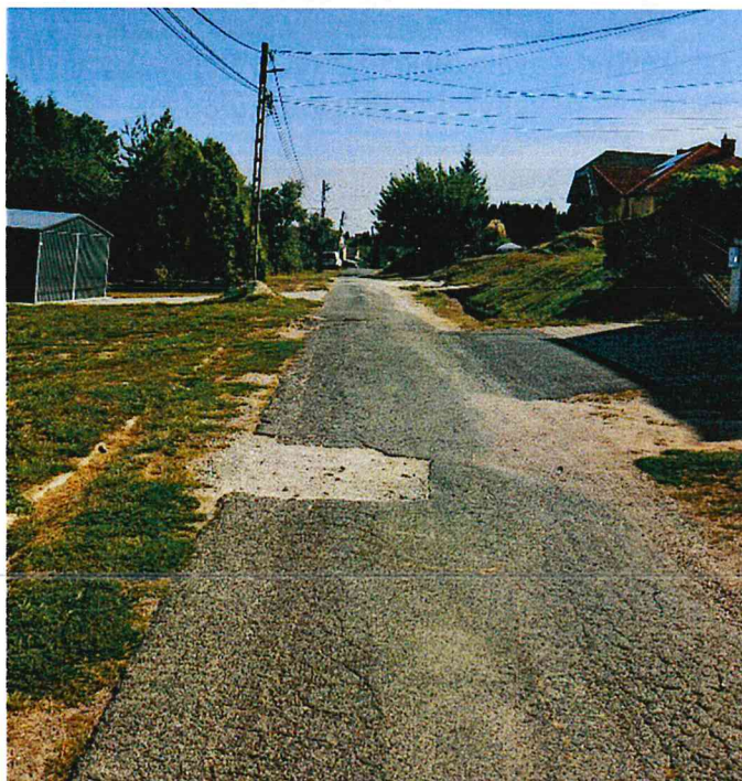
767/1 hrsz.-ú ingatlan előtt burkolatbontás víz- és szennyvízbekötés helyreállítása lehet
