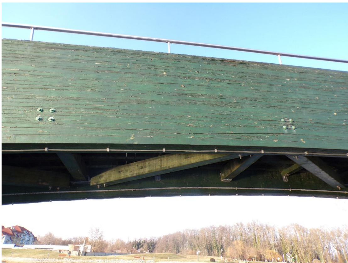
31. ábra: Réteg elválások, felületkezelés kopásai az A tartón
