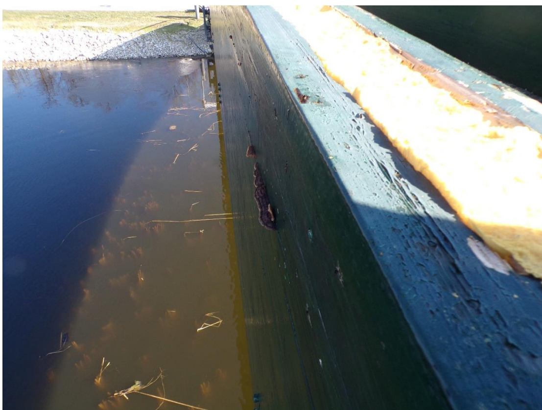
12. ábra: Cifra lemezestapló termőtestei, felül utólag kitöltött korhadt lamella részlete
