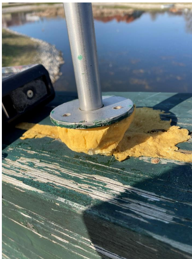
25. ábra: PUR habbal kitöltött korhadt faanyag és „rögzített” korlát rögzítés
