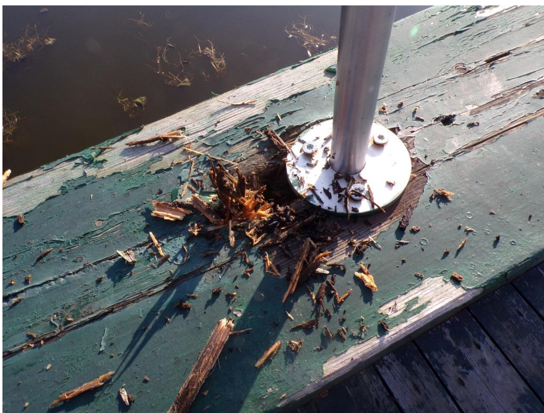
24. ábra: Feltárt, a felmérés időpontjában is magas nedvességtartalommal rendelkező felső lamella a korlát rögzítés közvetlen környezetében
