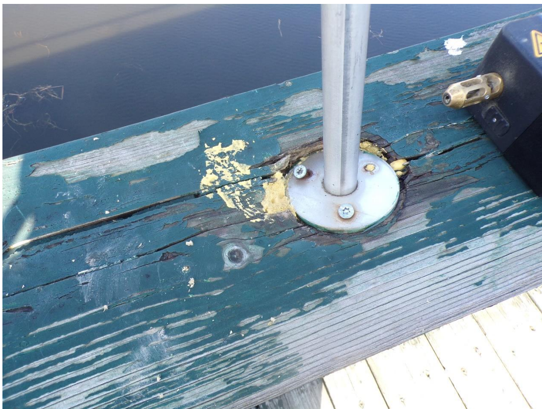
11. ábra: Korlát rögzítés közvetlen közelében korhadt, utólag PUR habbal kitöltött faanyag részlete
