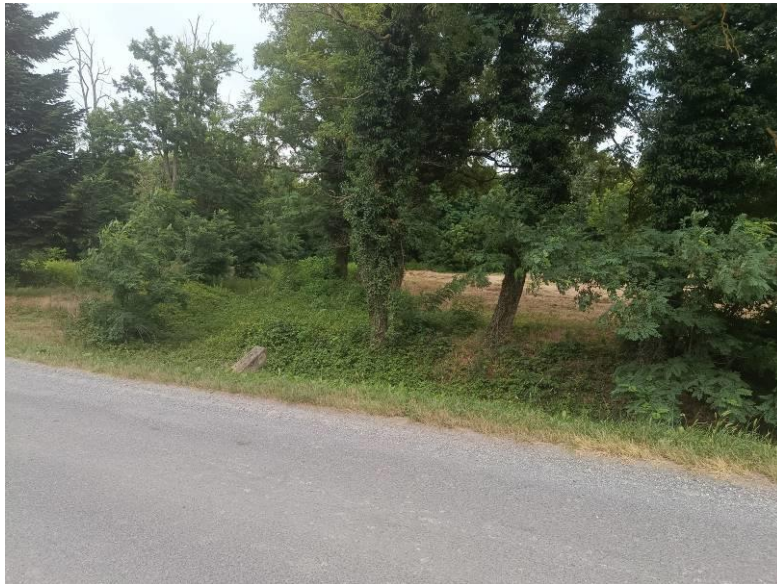
északi oldali határoló árok.
